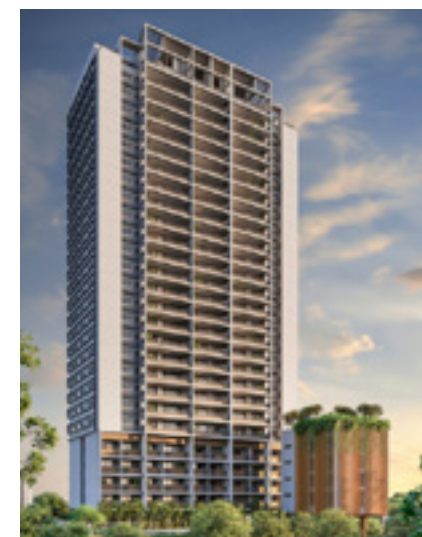
Botani - Em obras
